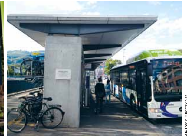
Olten: Bushaltestelle kombiniert mit einer großzügigen Radabstellanlage
