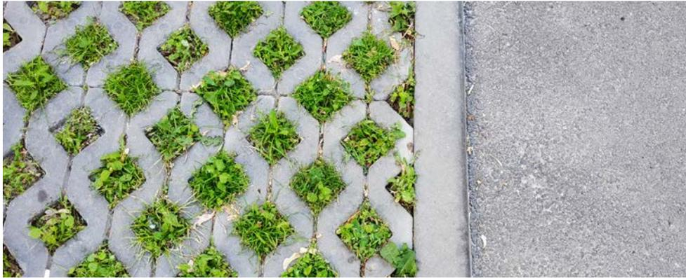
Abbildung 7: Pflaster mit aufgeweiteten Fugen und Natursteinpflaster mit Fugenvegetation, Bild: istock stanislava
